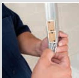
**1** Enlever la saleté et la graisse de la surface et retirer la feuille de protection de l'adaptateur.
