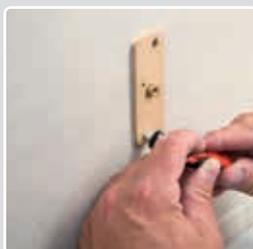
**3** Remplir les ouvertures avec la colle jusqu'à ce que celle-ci ressorte par les petits trous de contrôle.
