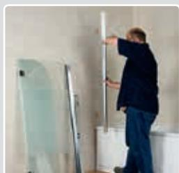
**2** Appuyer le profilé avec l'adaptateur contre le mur de manière à ce que l'adaptateur soit fixé au mur.
